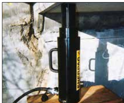
◀ Przenośne siłowniki RACL-1506 z nakrętkami zabezpieczającymi służą do długotrwałego obciążania podczas wstrzykiwania żywicy epoksydowej w ramach operacji wzmacniania mostów.
